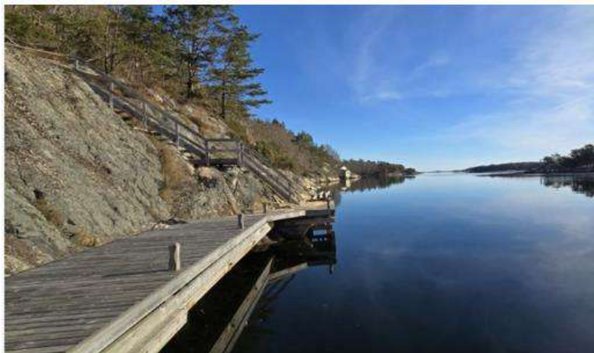
Figur 6-2 viser dagens adkomstbrygger slik det er utført i treverk. Foto: Agder Rådgiving AS.
