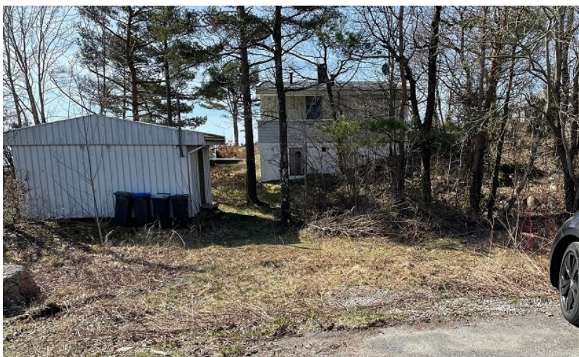
Nåværende bebyggelse sett fra Soloddveien (snuplassen) (foto 18.04.23)
