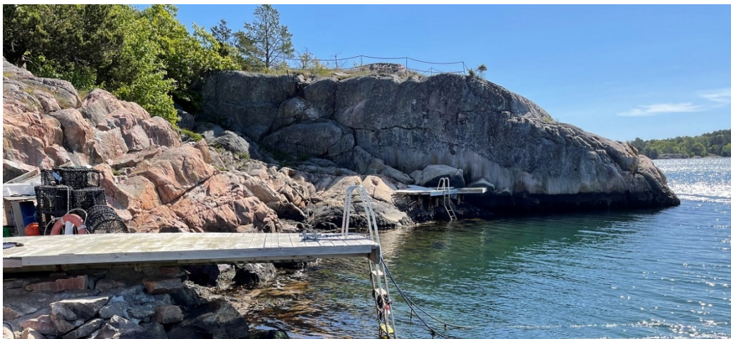
Sett mot skrenten i grensen mellom tomtene Soloddveien 64 og 66 (foto 30.05.23)
