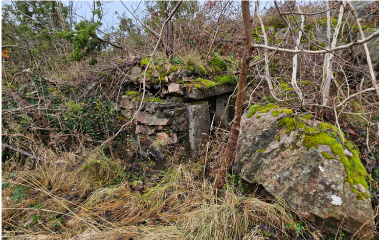
Installasjon registrert på befaring 13.12.2024
