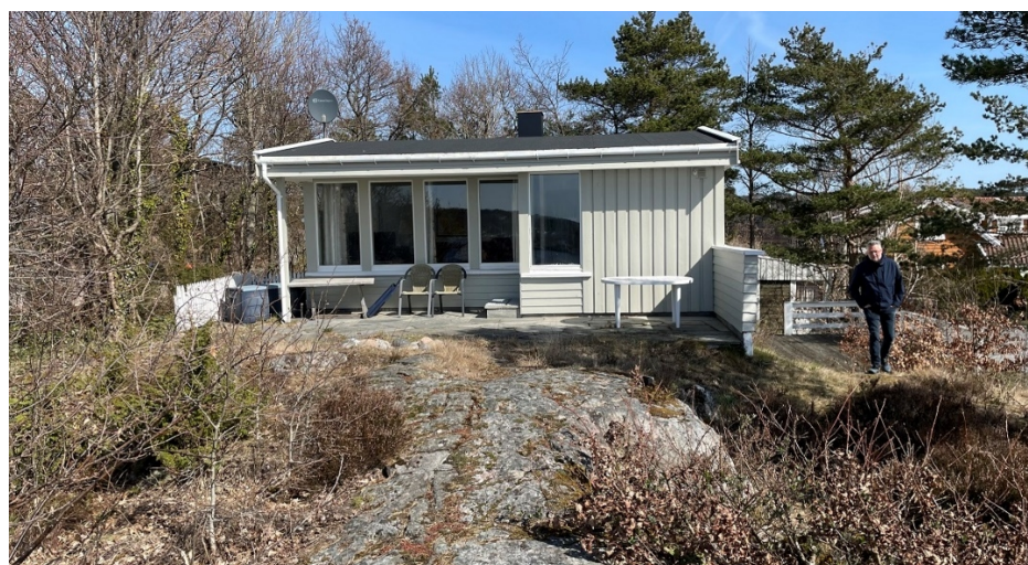
Nåværende hyttebygg, fasade mot syd/sjøen (foto 18.04.23)
