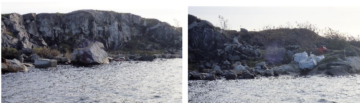
Bilde 7 og 8. Det gamle kalkbruddet observert fra sjøen B-D i kart 6.
