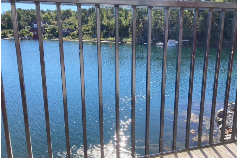
Balkong rekkverk i enkel utforming av stålspiler.
