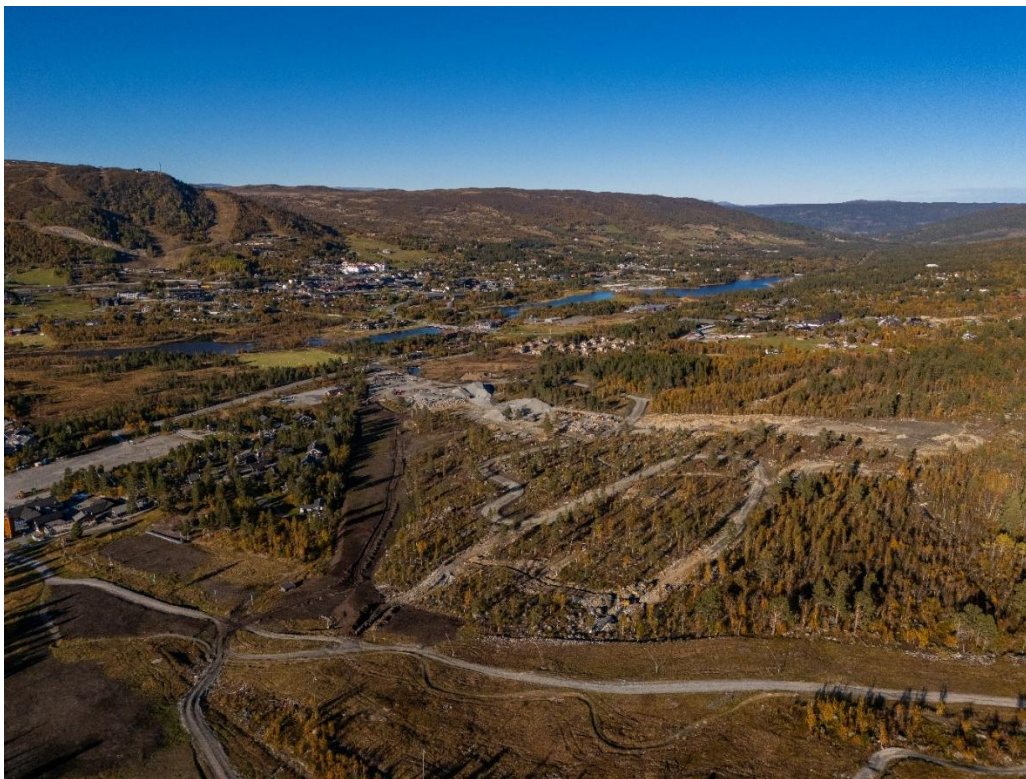
Figur 15 Oversiktobilde som viser utbygd infrastruktur høst 2025.
