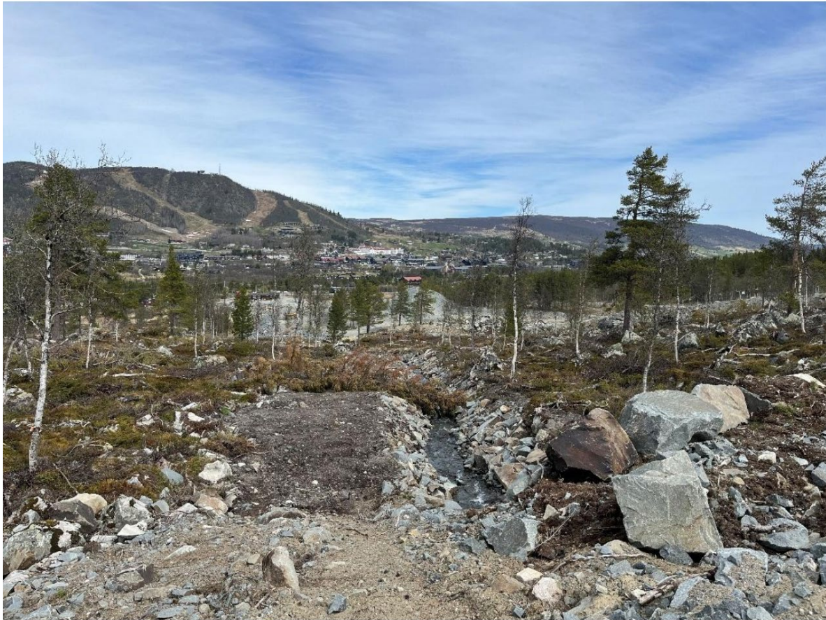
Figur 17 Bildet viser bekken gjennom planområdet som er plastret med stein som erosjonssikring
