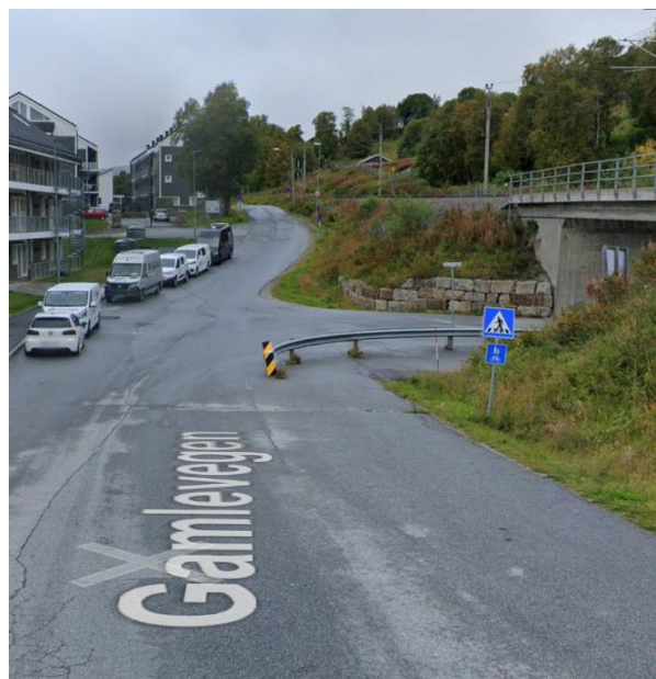
Figur 5-7. Eksisterende situasjon med autovern.
