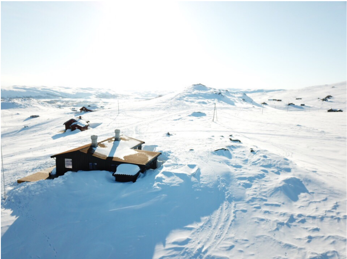
Oversiktsbilde 2, sett fra øst mot vest. Eksisterende bod mot øst med snø på taket.
