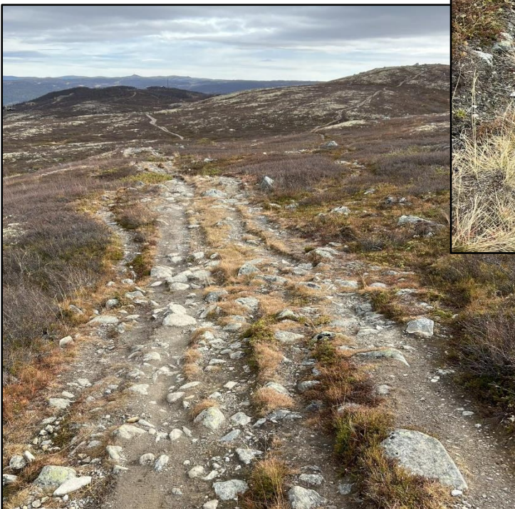
Bilder av de typiske problemstillinger som finnes i stien, med tydelige tegn til slitasje og fremskyndt erosjon.
