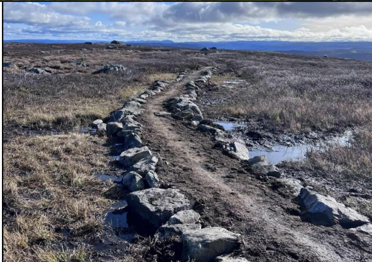
Myrpartiet mellom Urundberget og Geilohovda er utbedret (2023).
