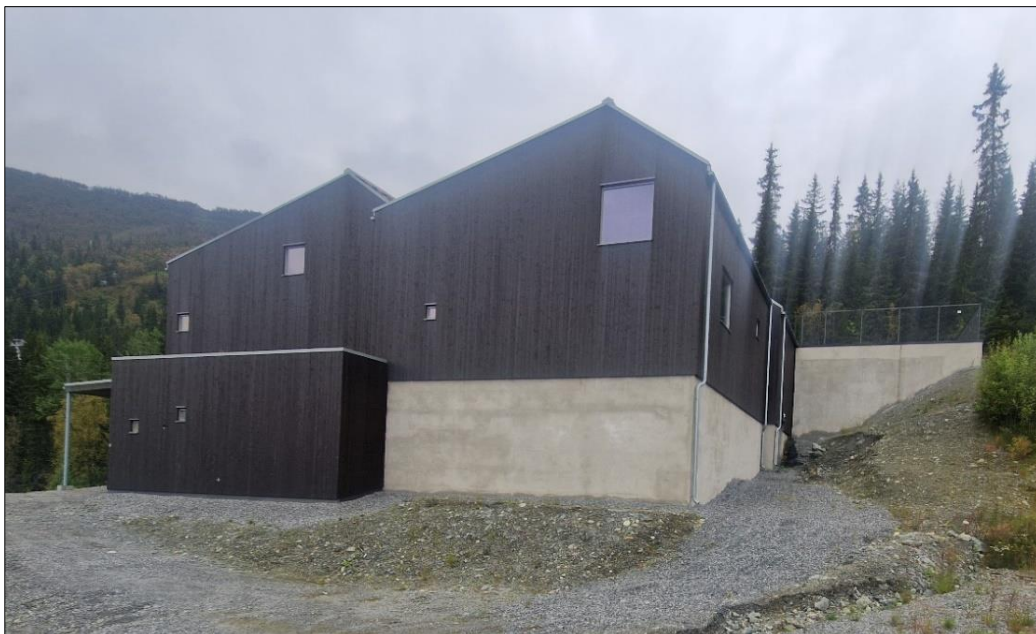
Figur 16. Holdebakken høydebasseng, Hemsedal kommune. Det er 2 stk 500 m 3 glassfibertanker som er plassert i nytt bygg. Eksisterende plass-støpt basseng på 1000 m 3 ligger bak nytt bygg
