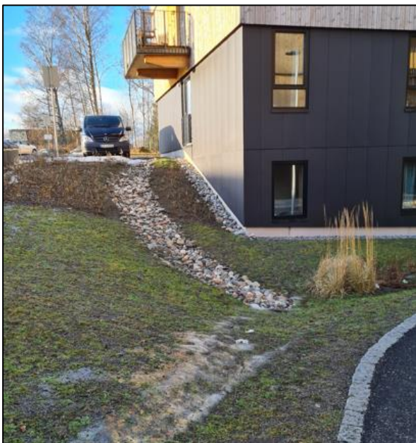
Figur 14: Overvann ledes på terreng i nedsenket grøntområde. Foto: Jan Inge Rygh.
