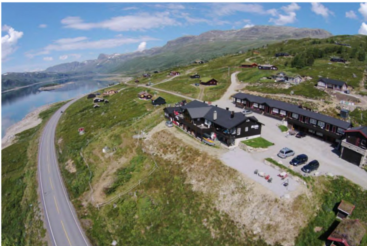
Figur 2: Bildet viser Storestølen Fjellhotell med fritidsbebyggelsen vestover (bilde: www.storestolen.no )-
