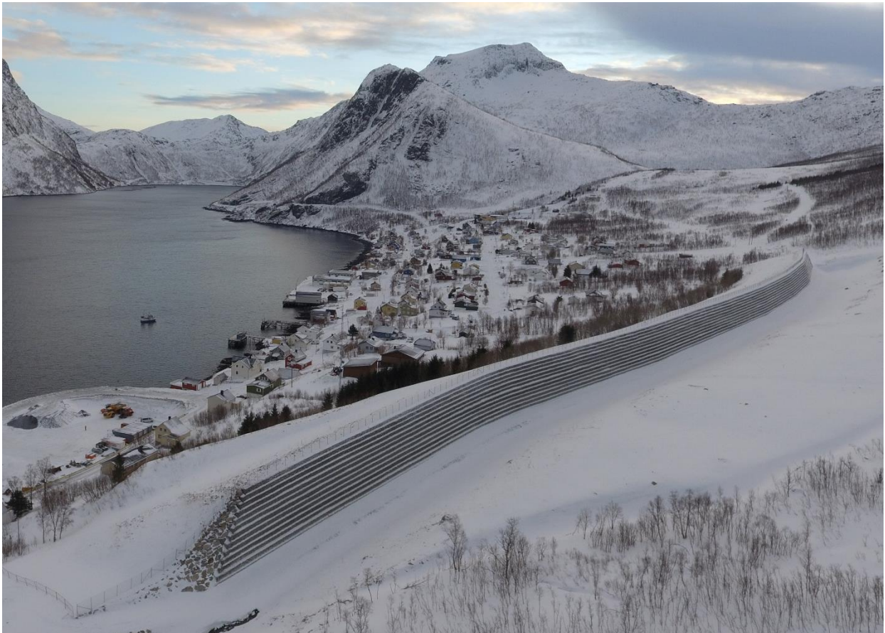
Figur 23: Fangvoll som sikrer bebyggelse mot snøskred. Foto: Skred AS.
