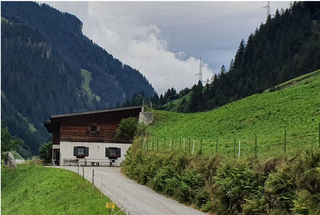
Figur 15: Eksempel på bygg som er bygd inn i en skråning slik at snøskred kan passere over taket. Foto: Skred AS
