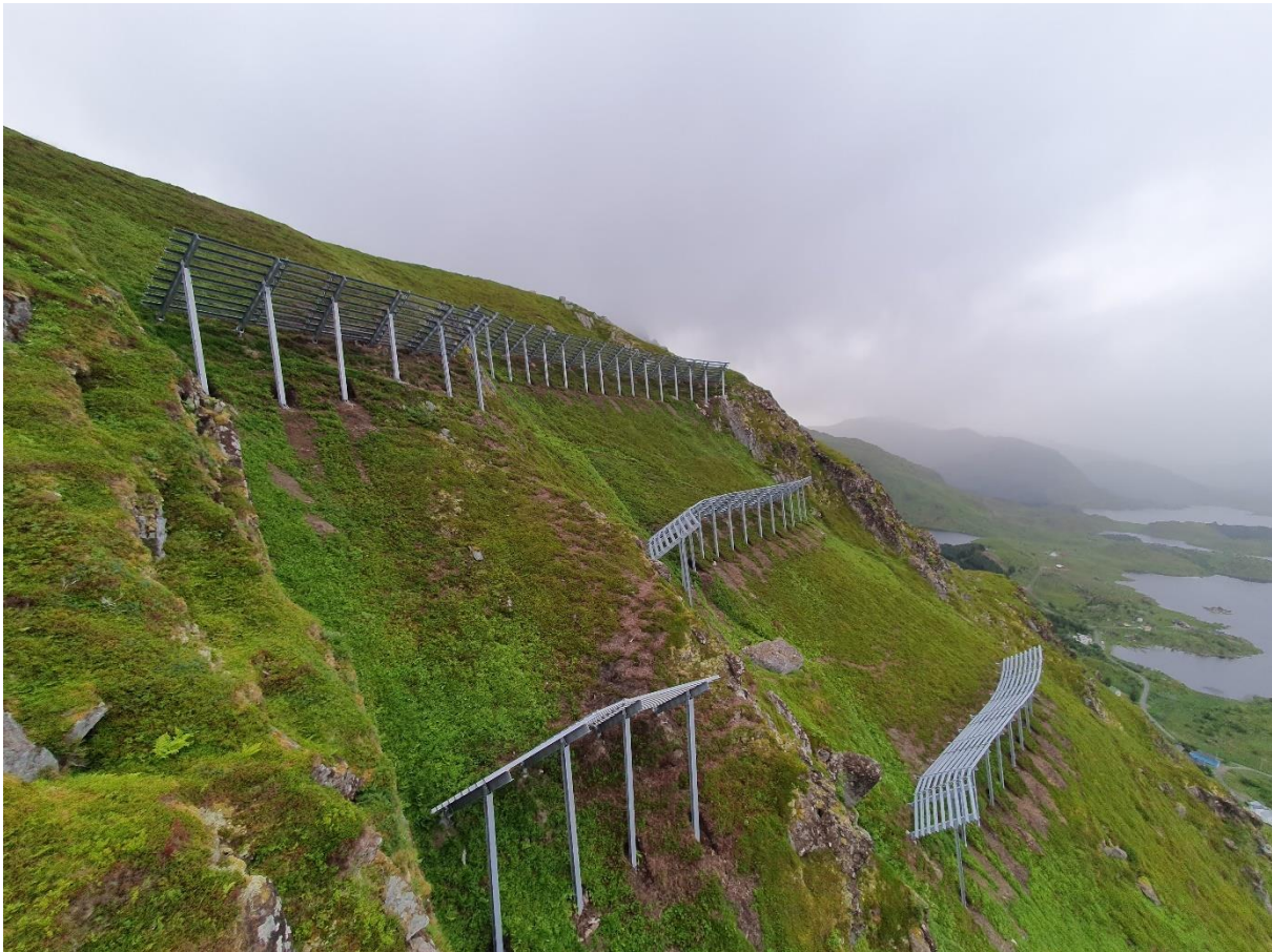
Figur 18: Eksempel på støtteforbygninger mot utløsning av snøskred. Foto: Skred AS
