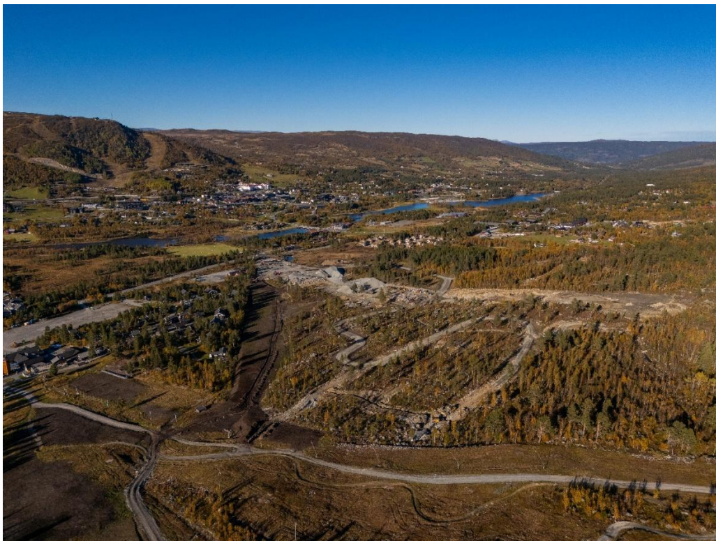
Figur 15 Oversiktobilde som viser utbygd infrastruktur høst 2025.
