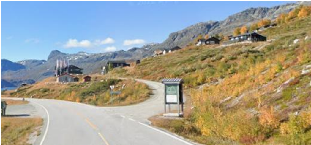
Området sett fra fv. 50
