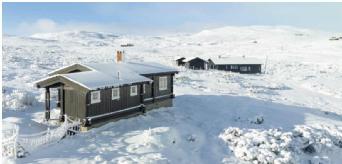
Bilde 2: Eksisterende hytte med 150 m 2 BRA nabohytte i bakgrunnen
