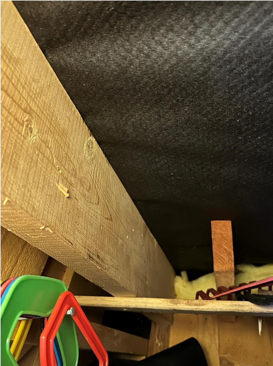
Bilde 10: Dimensjoner på takbjelker. 36 mm x 123 mm tresperr.
