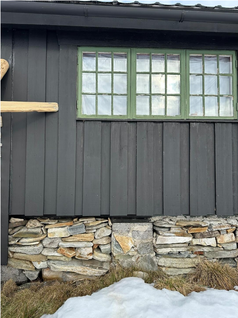
Bilde 9: Stablet stein mellom fundamenter på sør-vest veggen
