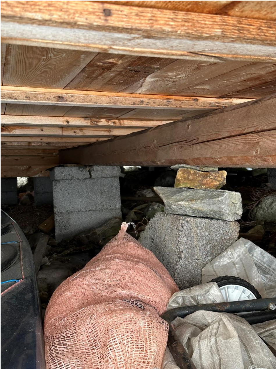
Bilde 3: Fundamenter under hytta
