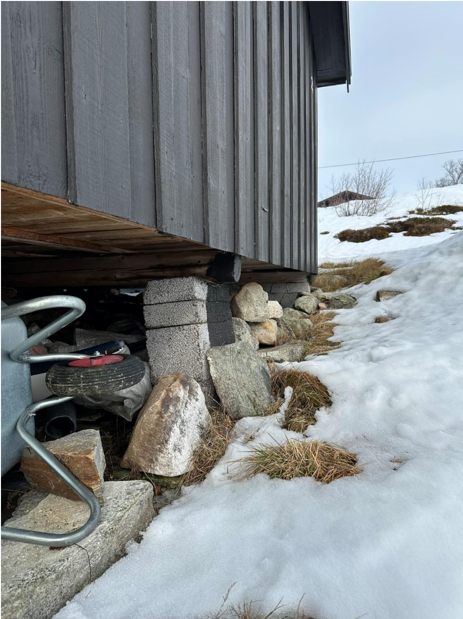
Bilde 2: Fundamenter under sørveggen
