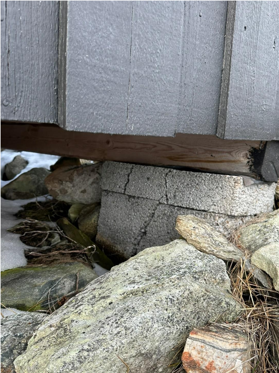
Bilde 4: Fundamenter under hytta
