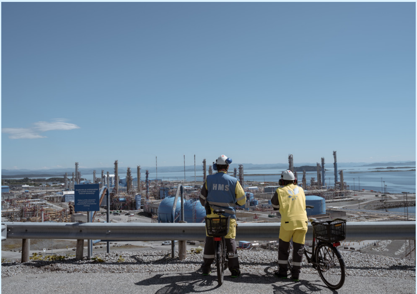
Kårstø-anlegget i Tysvær kommune. (Foto: Equinor)
