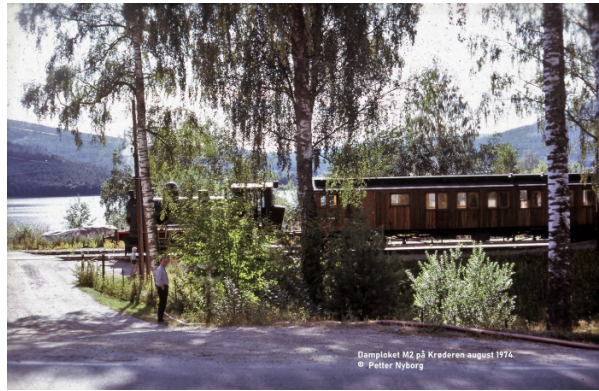
Situasjon fra før Fv 2894 ble lagt gjennom stasjonsområdet 1974
