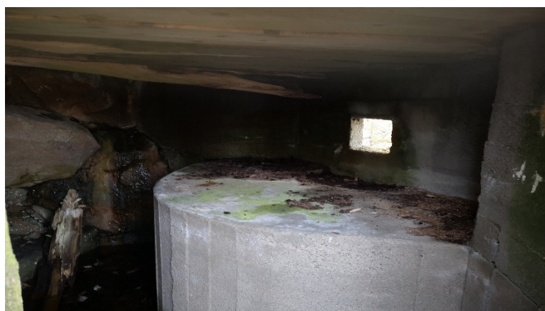
Bilde 4. Bunkers/skyte stilling, fra 2. verdenskrig. Skyte retning mot Audna / Rødberg.
