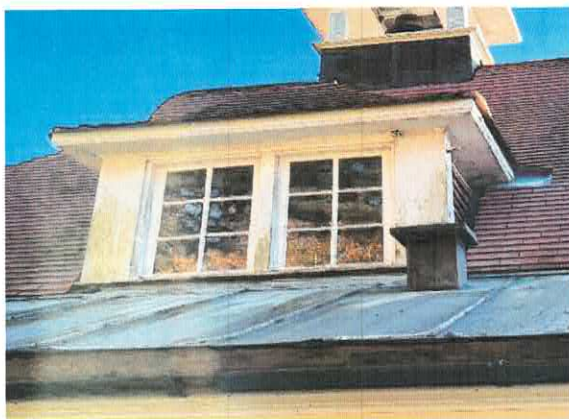
Båndtekking på Klokkehuset.
