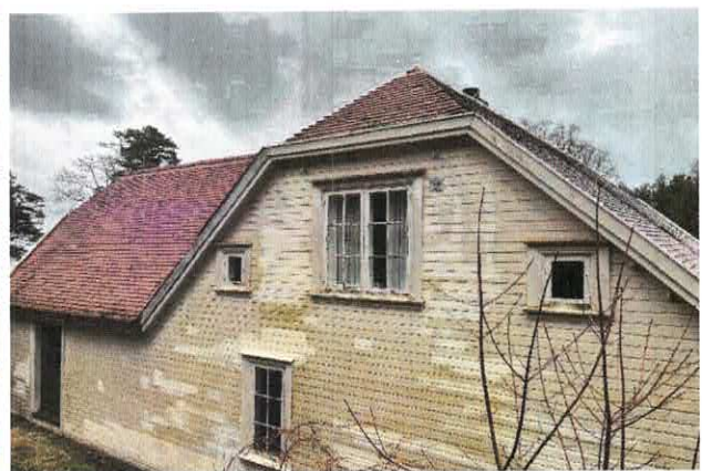
Bakvegg på forpakterboligen
