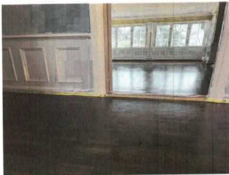
Gulv i kafe og gang etter tilbakeføring.
