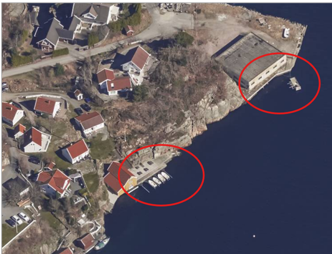
Figur 10. Rød ring til venstre viser eksisterende båt plasser. Rød ring til høyre viser hvor det er foreslått 6 nye båt plasser. Foto: Skråfot, kommunekart.
