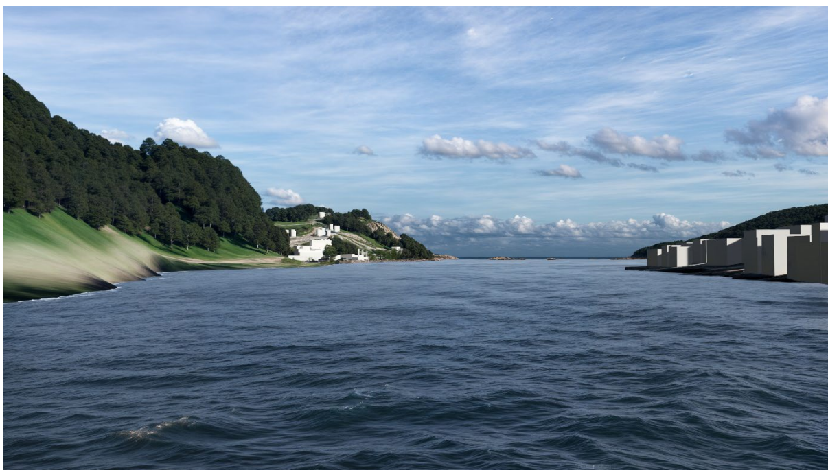
Figur 30: Utsikt mot planområdet fra fylkesvei 460, innerst i vågen. Fra denne vinkelen fremstår utfyllingsfronten som lite fremtredende, og terreng og vegetasjon bidrar til å skjule deler av den nye bebyggelsen, slik at tiltaket oppleves underordnet landskapsrommet.
