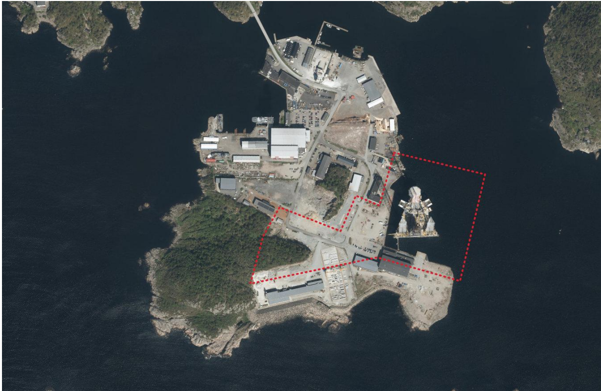
Figur 7.1. En stor del av Gismerøya er allerede opparbeidet til industriformål, og kun en liten del av planområdet har naturlig vegetasjon.
