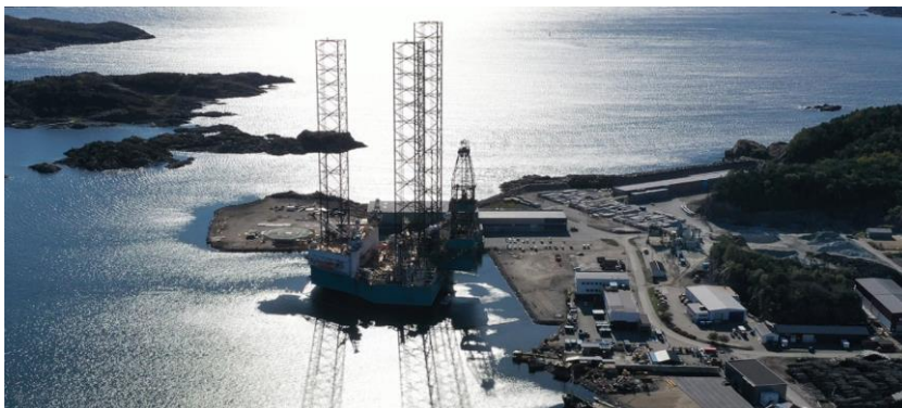
Figur 9 Eksisterende virksomhet med jack-up-rigg (Windport Mandal).
