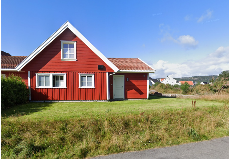
Figur 4. Viser eksisterende hus som grenser til byggeområde som er omfattet av endringen. Husene ligger på rekke mellom Bålyveien og Bålymoen, og er identiske. Byggeområdet B1 vil være fortsettelsen av denne rekken.
