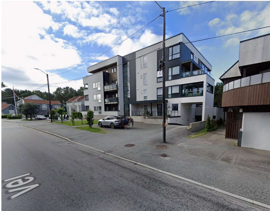
Figur 3 – gatebilde av bebyggelse mot Fridtjof Nansens vei hentet fra Google Maps. Planlagt gangsti etableres mellom bebyggelsen til høyre i bildet.
