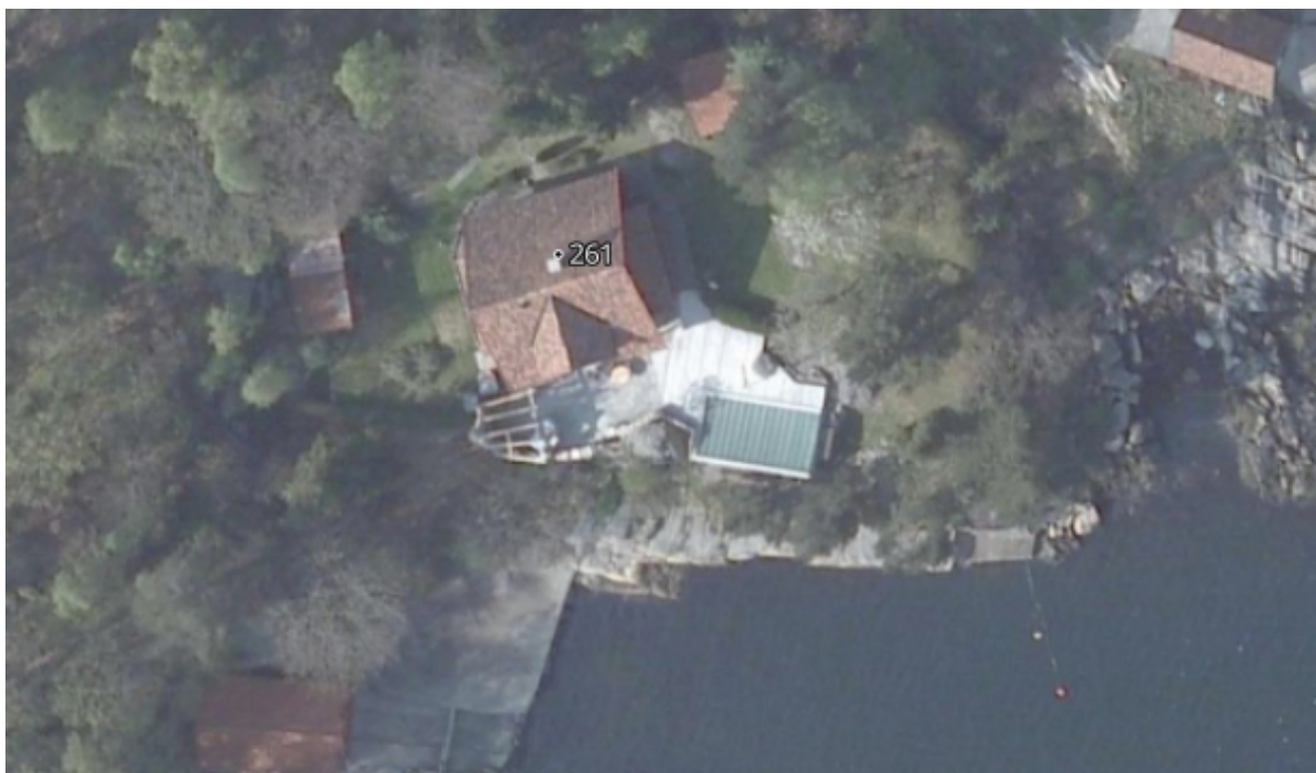
Figur 7. Flyfoto av eiendommen 2009. Ser man at det settes opp reisverk, samtidig som er det bygge- og deleforbudet i området.
