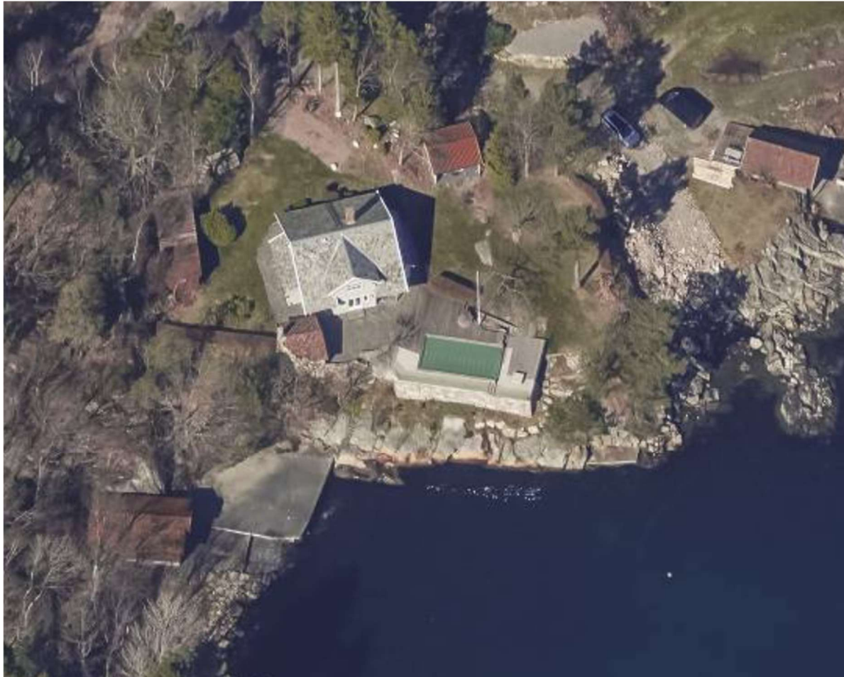
Skråfoto av for eiendommen.
