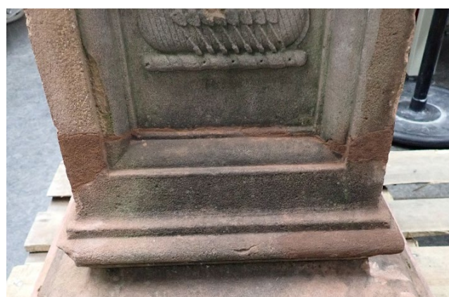
Figur 11) Foto t.v.: Mørtelreparasjoner før fargetilpasning. Foto t.h.: Mørtelreparasjoner etter fargetilpasning.
