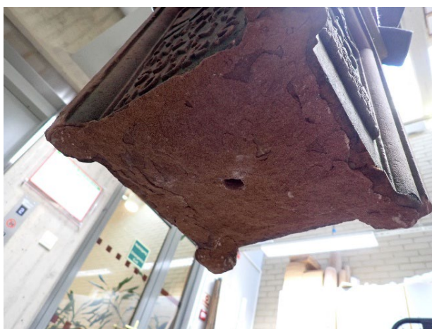
Figur 3) Detaljbilde av bruddet nederst på søylen. Foto t.v.: Før overflaten ble boret. Foto t.h.: Etter behandling med den samme pinnen, 15 mm i diameter.
