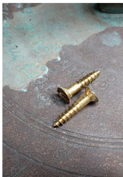
Figur 13) Foto t.v.: Skruene ble forsiktig demontert, rensed, polert og gjenbrukt. Foto t.h.: Skiven ble rensed og polert.
