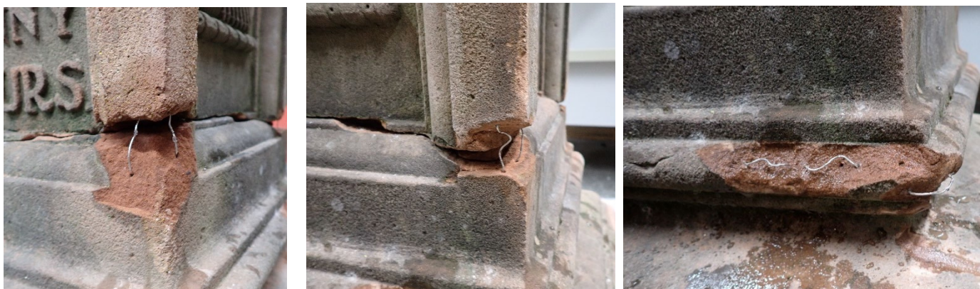
Figur 9) Tynt ståltråd ble festet på to hjørner og én profil for å gi støtte og oppbygning til mørtelreparasjonen.
