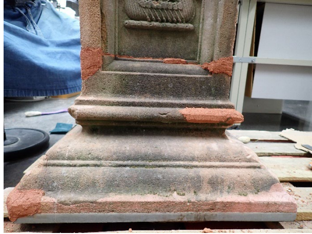
Figur 10) Foto t.v.: Påføring av mørtel for å gjenskepe de opprinnelige profilene. Foto t.h.: Før fjerning av overskuddsmørtel.
