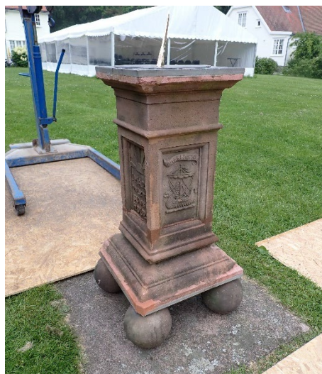
Figur 15) Foto t.v.: Montering av solurets hoveddel på de fire føttene. Foto t.h.: Etter fjerning av stroppene og øvrige mekaniske støtter.
