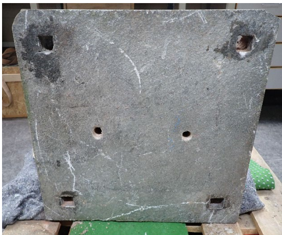
Figur 6) Foto t.v.: Skiferplate nederst av basen. Hullene var allerede boret tidligere. Inne i sandsteinen var de sirkulære i tverrsnitt, mens de ytre åpningene i skiferen var firkantede. Foto t.h.: Det ble derfor laget metallhylser som passet tett inn i åpningene. Disse ble senere kappet ned.
