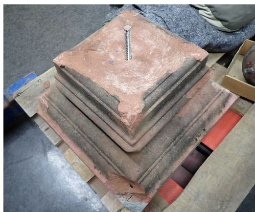
Figur 2) Rent brudd i overgangen mellom basen og resten av søylen. Foto t.v.: Før overflaten ble boret. Foto t.h.: Etter behandling med en pinne plassert i midten.
