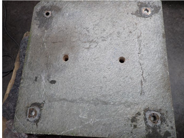
Figur 7) Metallhysene ble deretter festet permanent i hullene.
