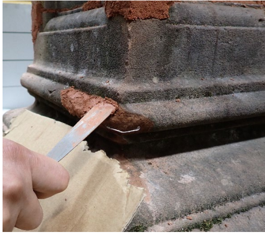
Figur 10) Foto t.v.: Påføring av mørtel for å gjenskepe de opprinnelige profilene. Foto t.h.: Før fjerning av overskuddsmørtel.
