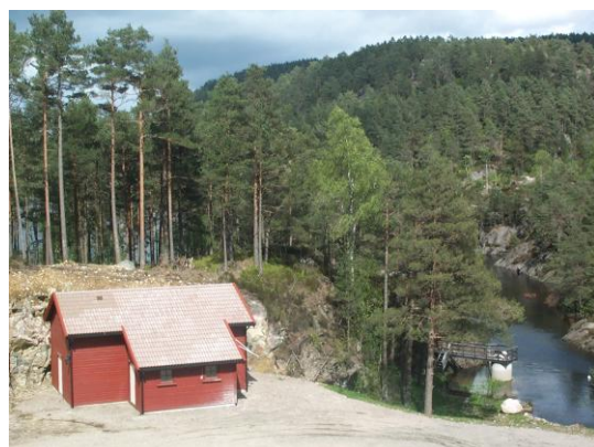
Kalkdoseringsanlegget i Høyåna , bygd 2004.
