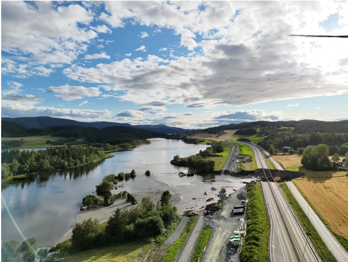
Foto: Droneberedskap Trøndelag - Kvikkleireskredet ved Nesvatnet i Ronglan i Levanger
