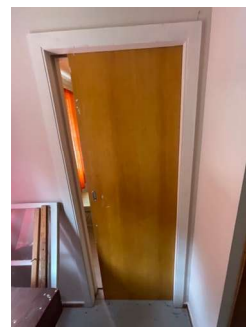
Skyvedør i 2. etasje har normal funksjon.
