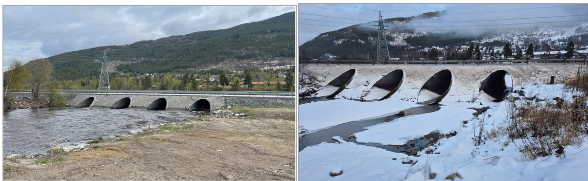
Figur 3.5: Rukkedøla, kulverter gjennom veifyllingen av rv. 7, 07.05.2024 og 26.11.2024.
