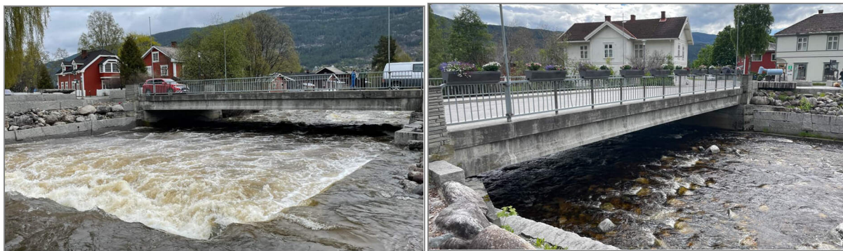
Figur 3.3: Hajem bru sett fra oppstrøms, 07.05.2024 og 19.06.2024
