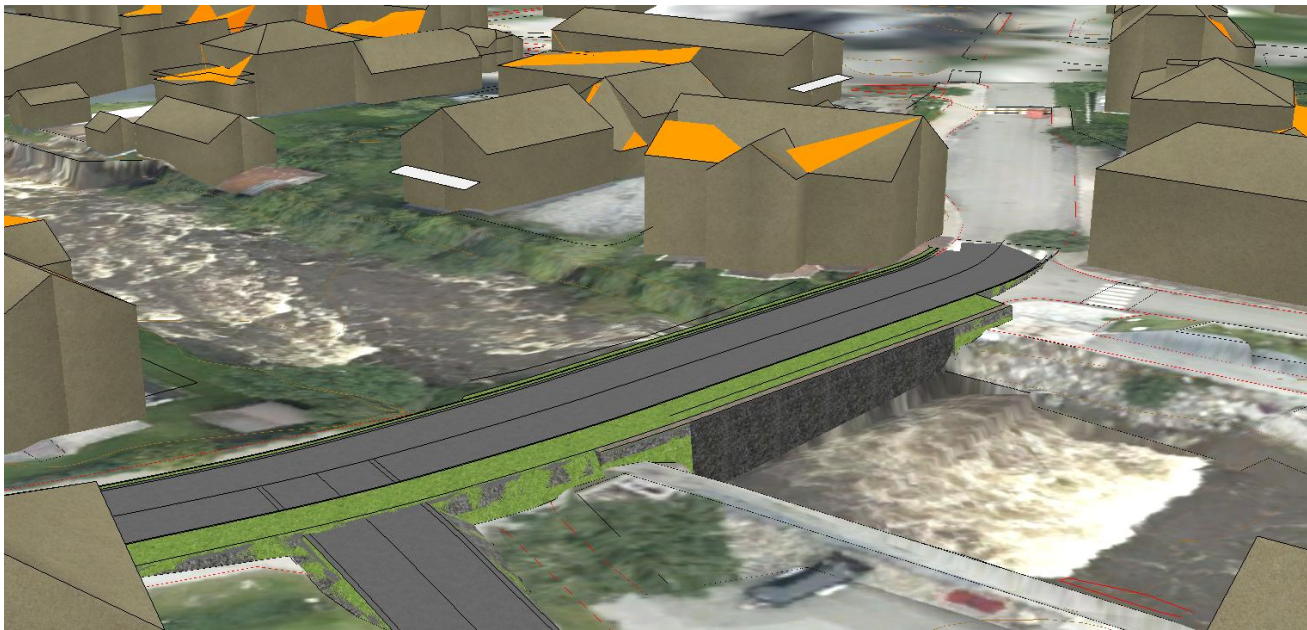
Figur 32. Ny Hajem bru sett fra oppstrøms.
