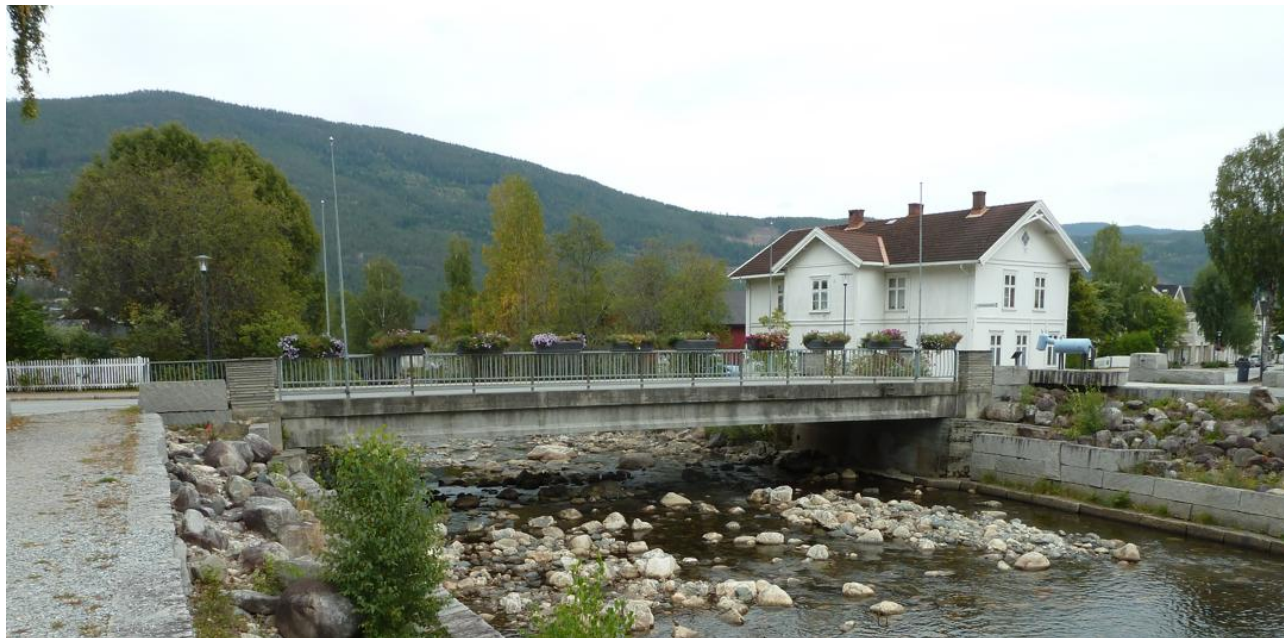
Figur 28. Eksisterende Hajem bru. Bildet er tatt 27. august 2025.
