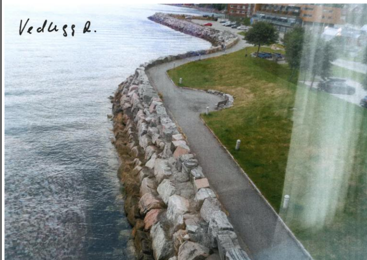
Plastring av kantene der kanalen kommer ut i Borgåa
