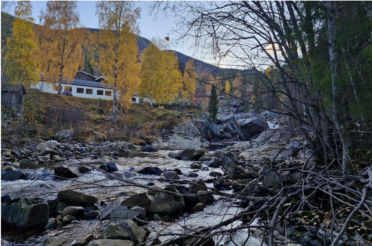
Figur 2: Bilde fra befaring som viser blokker og vegetasjon som har blitt transportert av flom i Rukkedøla.
