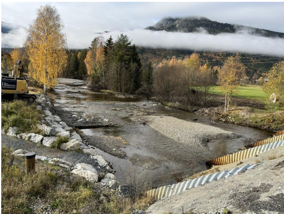
Figur 3. Rukkedøla oppstrøms kryssingen under Rv7. Bildet viser eksempel på dynamisk grusavsetning i elva.
