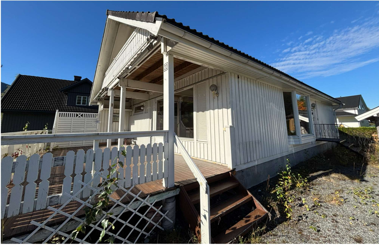
Foto fra befaring, 24. september 2025.
