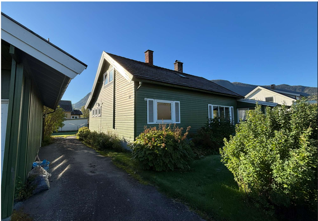
Eneboligen i Stasjonsvegen 44, foto tatt av undertegnede ved befaring den 24. september 2025.
