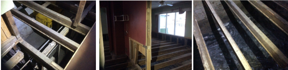
Figur 2. Bilder tatt under befaring den 12.01.2024
