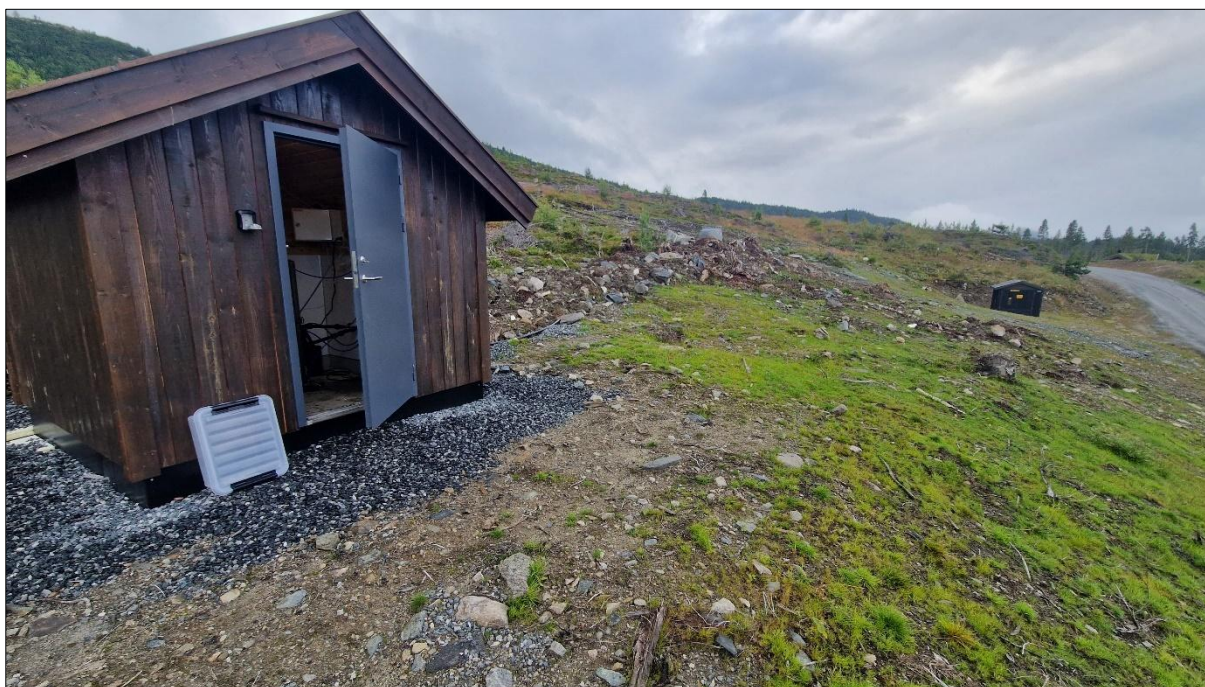
Figur 8. Vannbehandlingsbygg ved Sundbolien størrelse 2,5 x 3 meter
