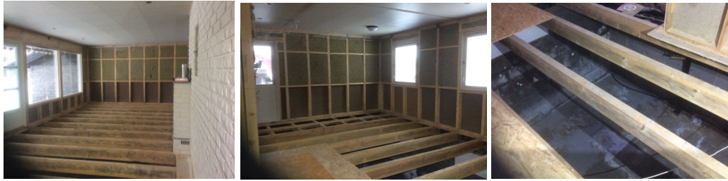
Figur 2. Bilder tatt under befaring den 21.12.2023
