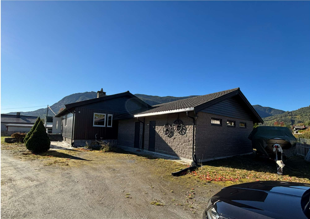
Foto fra befaring, 24. september 2025.
