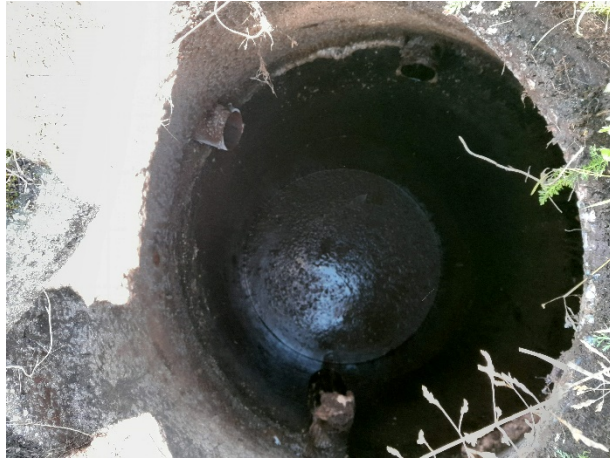
Foto 1 - eldre betongkum på eiendom 56/38 Eidalsvegen 19 (27.07.2023)
