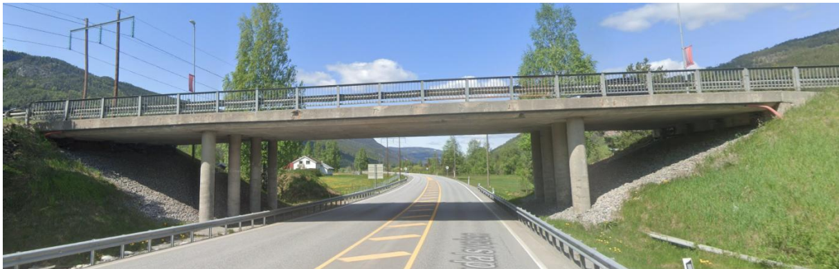
Figur 5: Eksisterende bru sett fra syd mot nord (Google street view)
