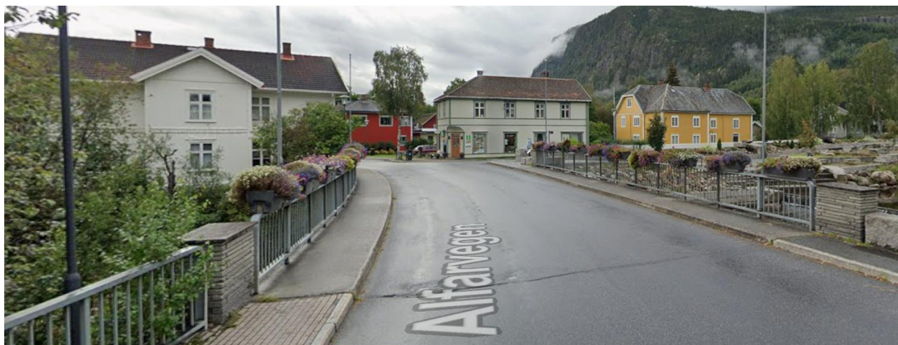
Figur 29. Eksisterende Hajem bru. Bildet er tatt 27. august 2025. Smale fortau på begge sider.
