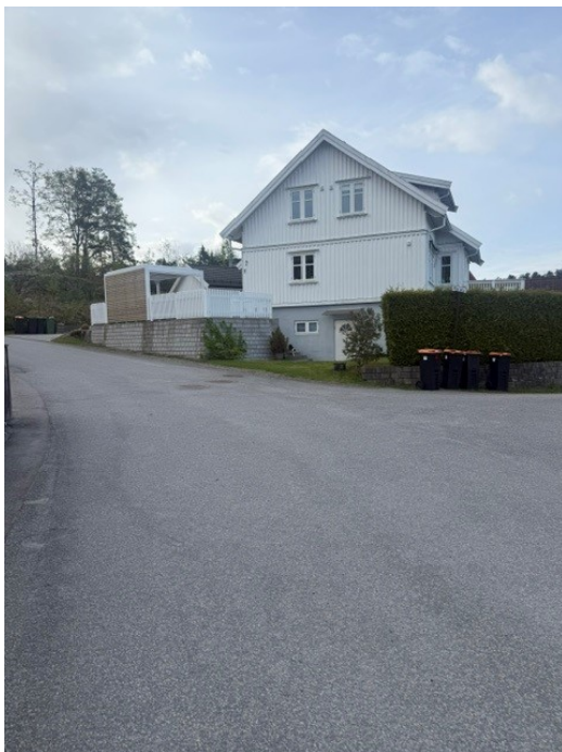
Røralia 2 fra veg
