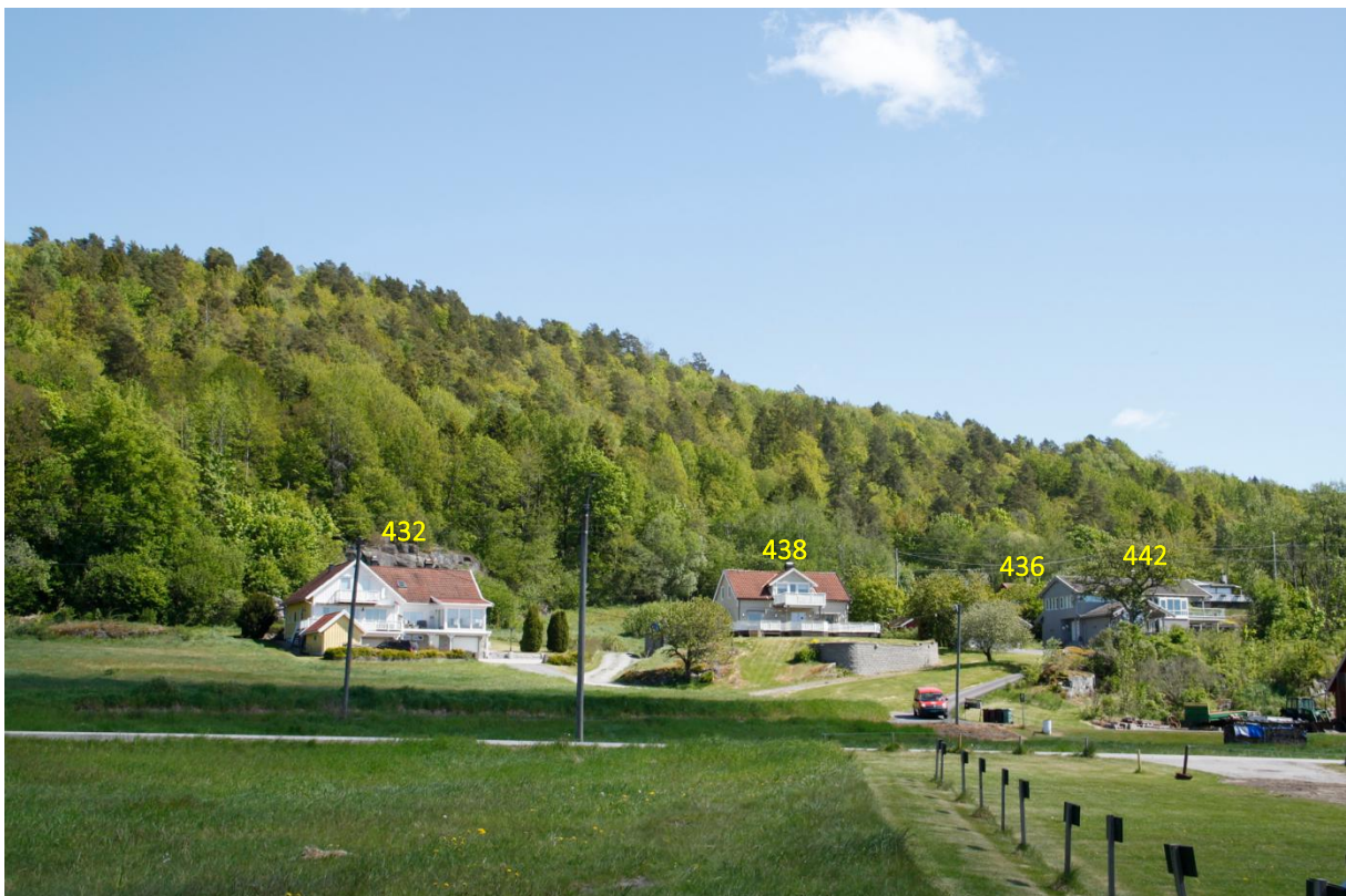
Fig. 16: Eksisterende situasjon ved Bergsbygdavegen 432-442.
