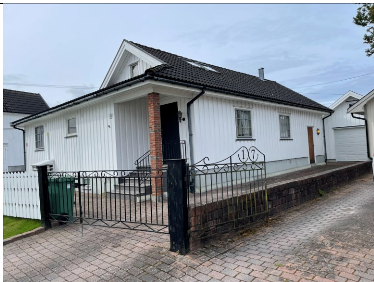
Skolegata 19 Bygg jærhustak. Hovedetasje med h-vindu toppturn med småruter. Kjeller med lave vinduer. Loft med vindu i gavl og takflate for lys og bruk av loftsareal
